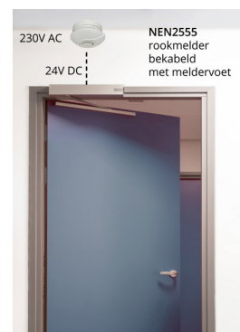
Aansturing deurdranger door rookmelder
